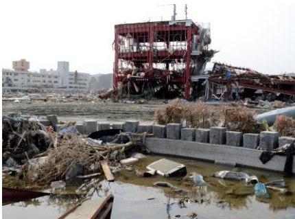
南三陸町の防災対策庁舎が鉄骨の骨組みだけを残した ©日本ユニセフ協会/2011/K.shindo
